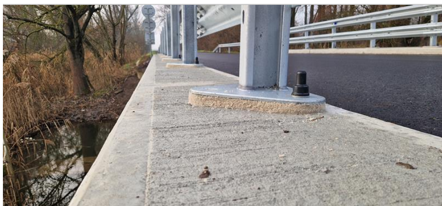
podlité kotevní svodidel
