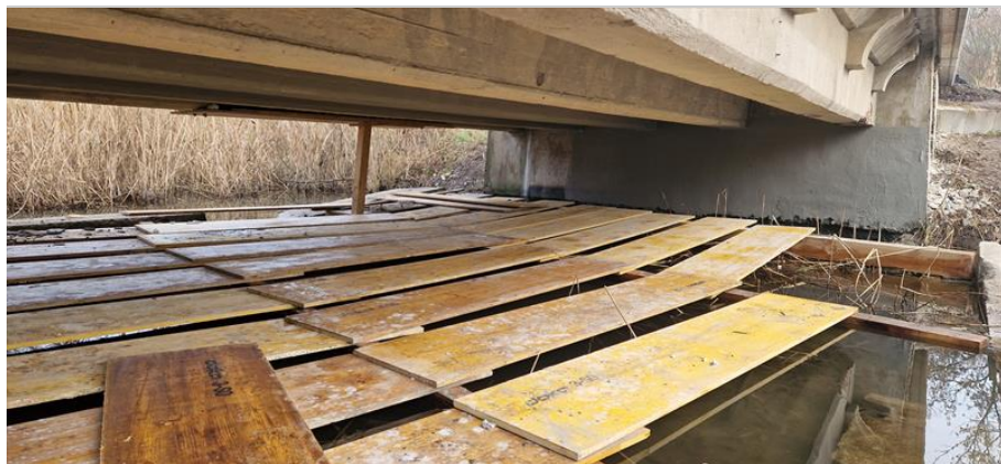
podhled NK a povrch opěr ještě čeká oprava
